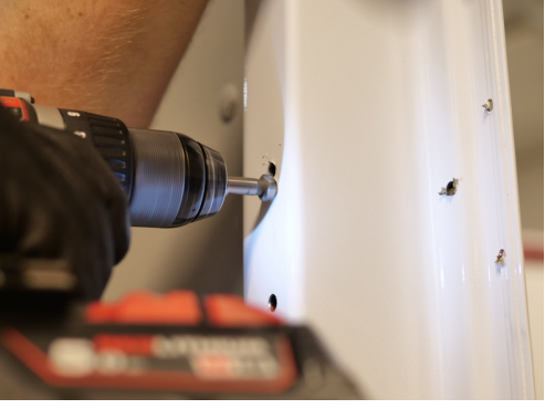
C. Borra alla 3 hålen till 4mm
