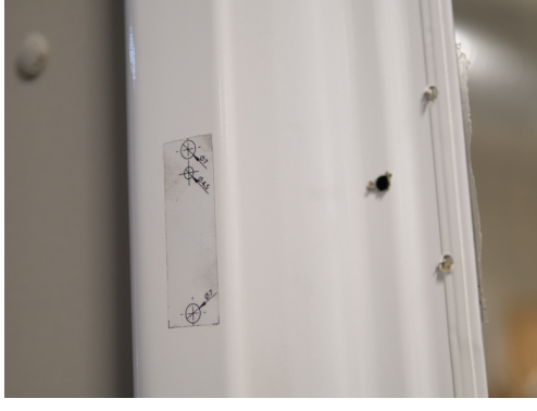
A. Klistra på bormmallen på stolpens insida
