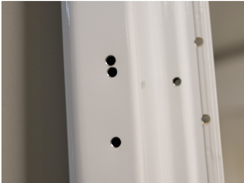
D. Borra alla 3 hålen till 7mm och grada av
