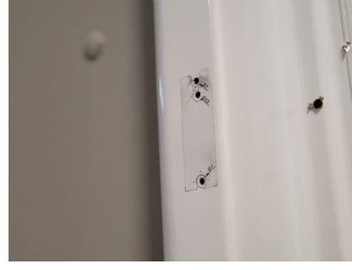
C. Borra alla 3 hålen till 4mm
